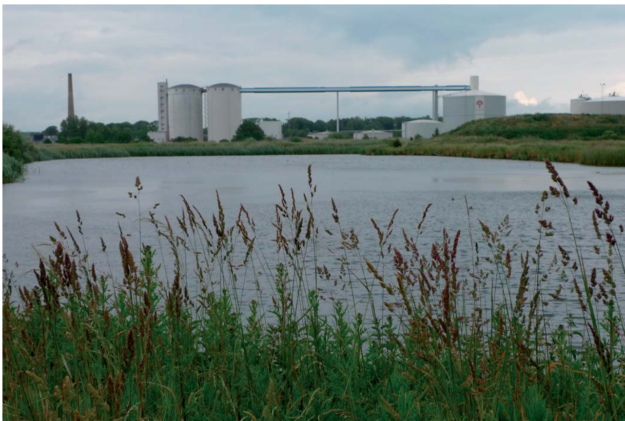
Fra jordbassinerne er der udsyn over Sukkerfabrikkens storskalaanlæg.
